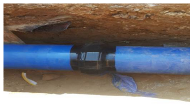
설치 완료 (수축비: 60%)
