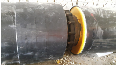
케이싱 설치(용접 전)
