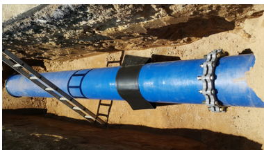
시트 설치 (플랜지 체결 전)
